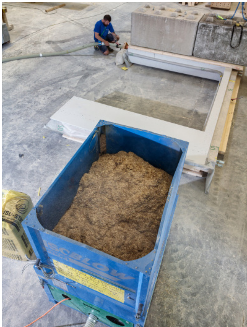
Gehexeltes Strohl (unten) wird mit Hochdruck in die Hohlräume der Bauelemente geblasen (rechts). Das ist viel nachhaltiger als Glaswolle.
