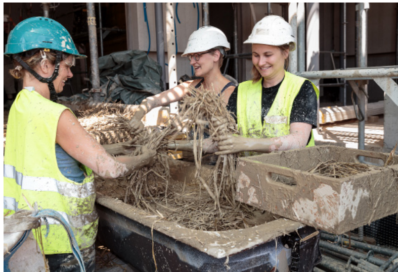
Eigenhändiges Ausfachen mit Lehm und Stroh ist aufwändig.
