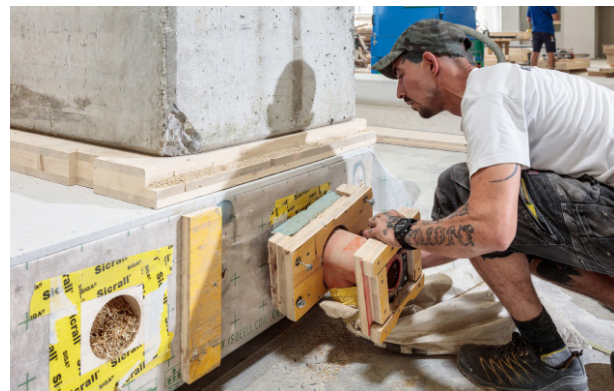
Gehexeltes Strohl (unten) wird mit Hochdruck in die Hohlräume der Bauelemente geblasen (rechts). Das ist viel nachhaltiger als Glaswolle.
