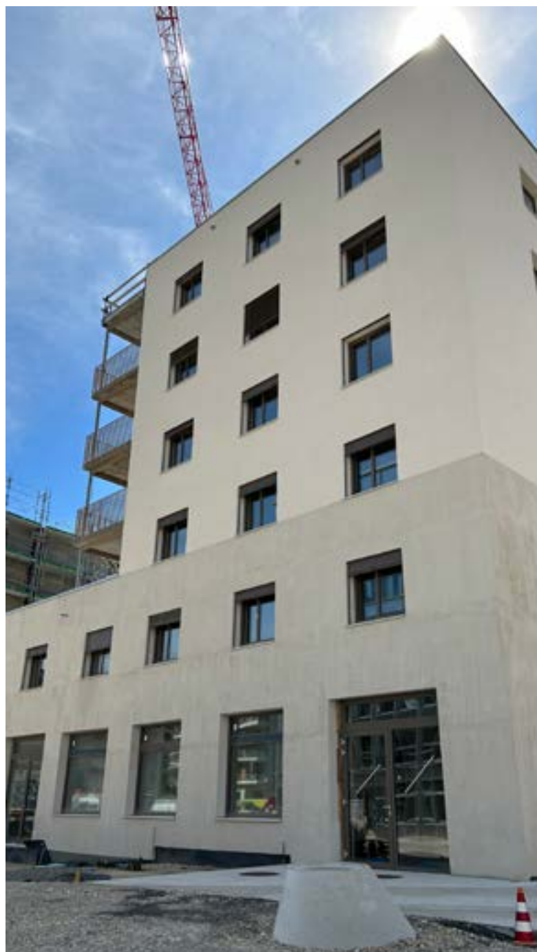
A terme, les façades seront habillées par des plantes grimpantes indigènes. DR/Stéphane Fuchs
